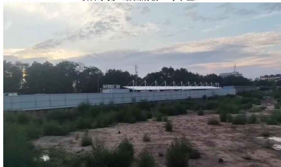
项目西侧（停车场）
